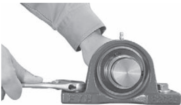
図 14.4 軸受ユニットを機台に固定
